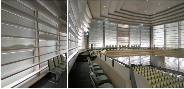
Abbildung 2: Akustikrollos hinter den horizontalen Strukturen (links) und Blick auf den Balkon (rechts)
